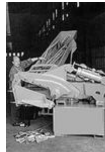
Ce type particulier de cisaille est une cisaille crocodile et est le choix le plus logique pour détruire des armes.
